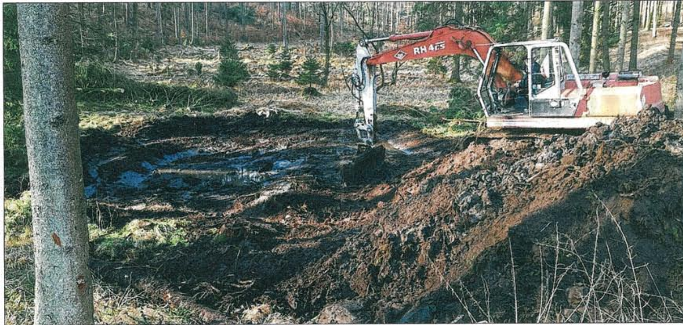
Mit Hilfe eines Baggers wurden die ausgetrockneten Flächen im Seeoner Martiniforst wieder freigelegt und bieten vielen Tieren einen neuen Lebensraum.
